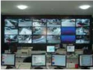
新疆某军区搭建的安防监控系统用于监控整个部队各个场所，前端配置了20多台监控服务器，后端监控室配置12块大屏幕，需要实现每块屏幕都能自由调取监控服务器上的画面以便安全监控。作为军队高级别的安全项目，需要一套稳定及方便的图像切换系统。
